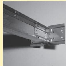
*Nota : Les embouts et les éclisses se posent symétriquement de part et d'autre du profil et sont fixés par des TRPF. Des avant trous  $\varnothing 3$  ont été percés ainsi que des trous  $\varnothing 5$  pour faciliter le centrage. Les éclissages des profils se font en quinconce.*
